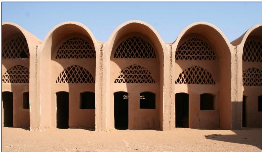
Фиг. 8. Вътрешна фасада на пазара. Всеки магазин има вентилационни решетки на две нива, Източник: Aga Khan Trust for Culture, фото кредит: Виола Бертини
