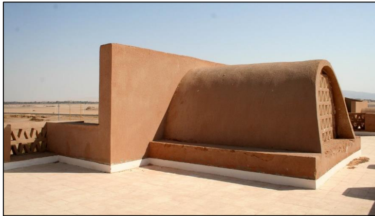
Фиг. 7. Покрив на сграда с цилиндричен висок обем („нубийски свод“), позволяващ вентилация на помещенията под него
