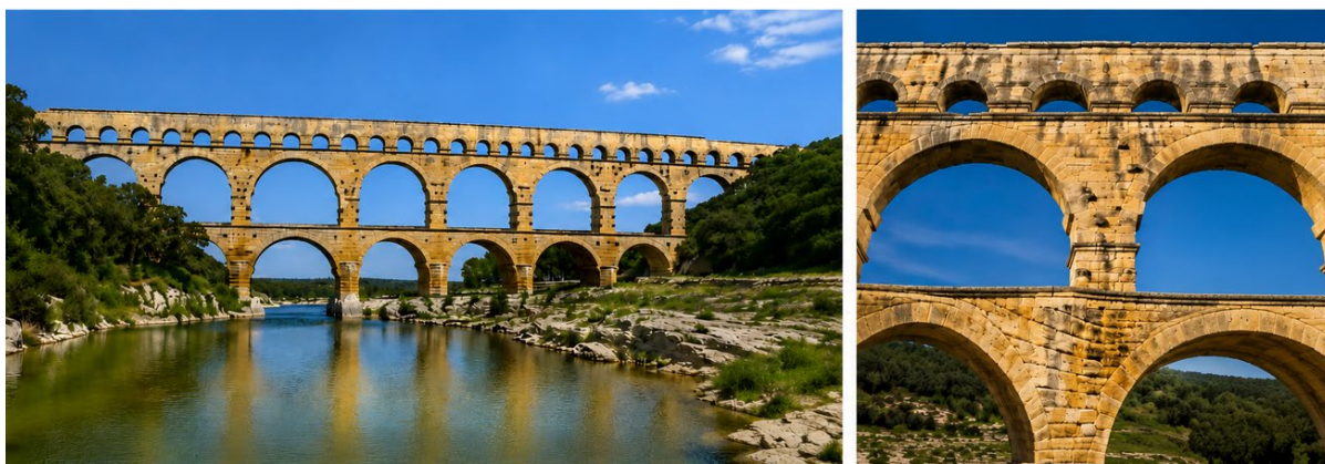
Фиг.5 Pont du Gard като класически пример за римска аркова система, при която устойчивостта се осигурява чрез непрекъснат компресионен силов поток и благоприятно положение на линията на натиск.
